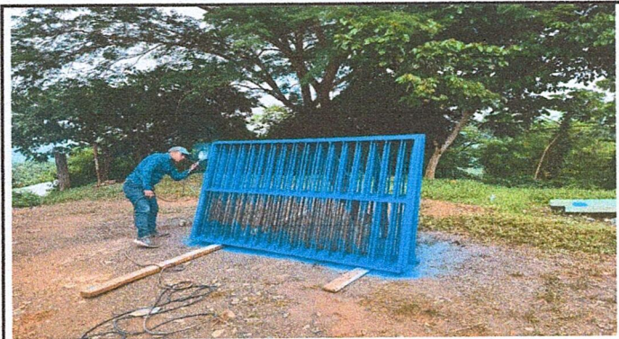
pintada de balcones
