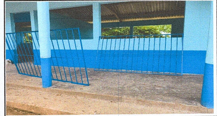
instalacion de balcones en modulo de escuela
