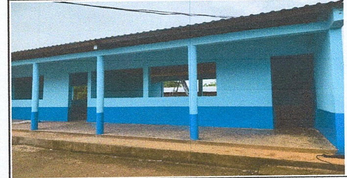
Pintada de interior y exterior de la escuela.
